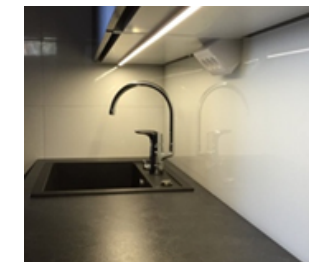
Keittiön välitilan valaisin LED- valonauha Ecolight
