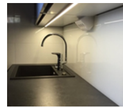
Keittiön välitilan valaisin LED- valonauha Ecolight
